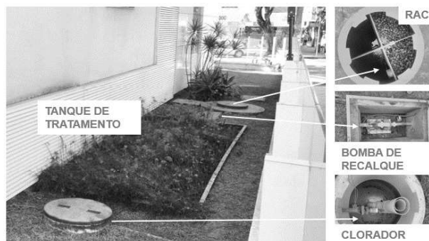
Figura 5. ETAC com wetland implantada no banco SICOOB.
